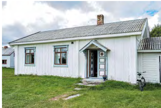
Den nåværende skolebygningen ble satt opp omkring 1876
