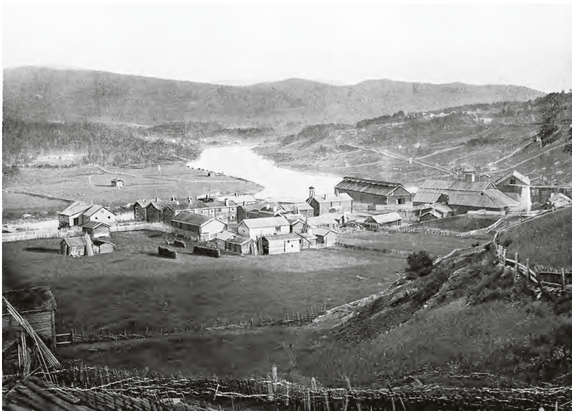
Tolgen hyttelass ca. 1865-1870. I midten på bildet kan en se «Hyttstua»(administrasjonsbygget) med klokketårn. Videre ser en venderøsthytta. Et stykke bak denne foregikk kaldrøstinga av malmen. Der heter det fortsatt «Røstvedhagen». Den største bygningen er selve smeltehytta. I den øvre enden av den kan en se den lyse pipa til garovnen. Bak denne igjen ser en toppen av kolhuset med ei lang, høy kjørebru inn mot mønet. Foto: Elen Schomragh
